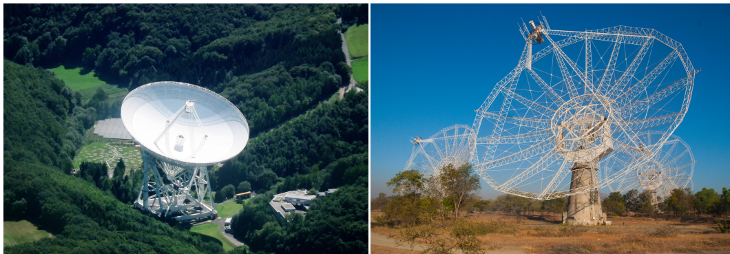
Figure 7.21: Links : de 100 meter Effelsberg radio telescoop in Duitsland. Het is 's werelds grootste volledig stuurbare radio telescoop. Rechts : drie van de in totaal 30 schotels van 45 meter diameter van de Giant Metrewave Radio Telescope (GMRT) interferometer in India. Bron: dr.G.Schmitz (Effelsberg); NCRA-TIFR (GMRT).
